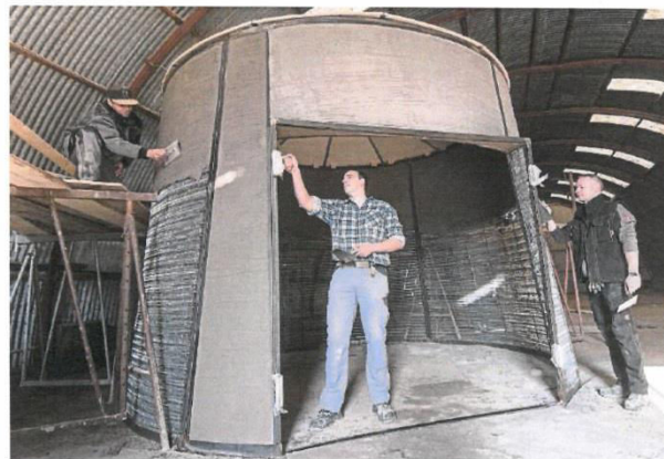
Geschäftsführer Jörg Bourgett hat sofort zugesagt, dass die Langzeitarbeitslosen in Beschäftigungsprogrammen der Wiesbadener Jugendwerkstätten den „Pavillon der Stille“ bauen werden, der Ende April auf dem Schlossplatz aufgestellt wird. In der Domäne Mechtildshausen arbeiten unter anderem Jeffrey Berghäuser, Coach Waldemar Martens und Peter Heflik an dem Projekt. Foto: wita/Uwe Stötz
